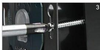
Прикрутите выключатель двумя винтами
